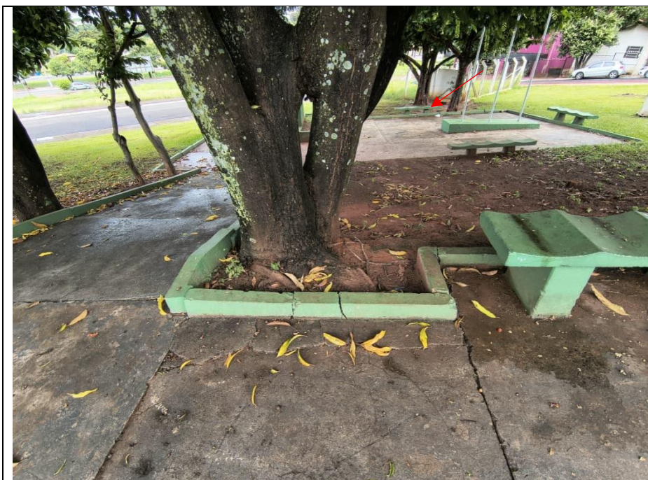
Figura 2 – O local apresenta desgaste significativo e patologias no pavimento , principalmente decorrentes do crescimento das árvores, sendo recomendadas intervenções de manutenção corretiva , como reparo do piso, recomposição dos canteiros e manutenção da pintura dos mobiliários
