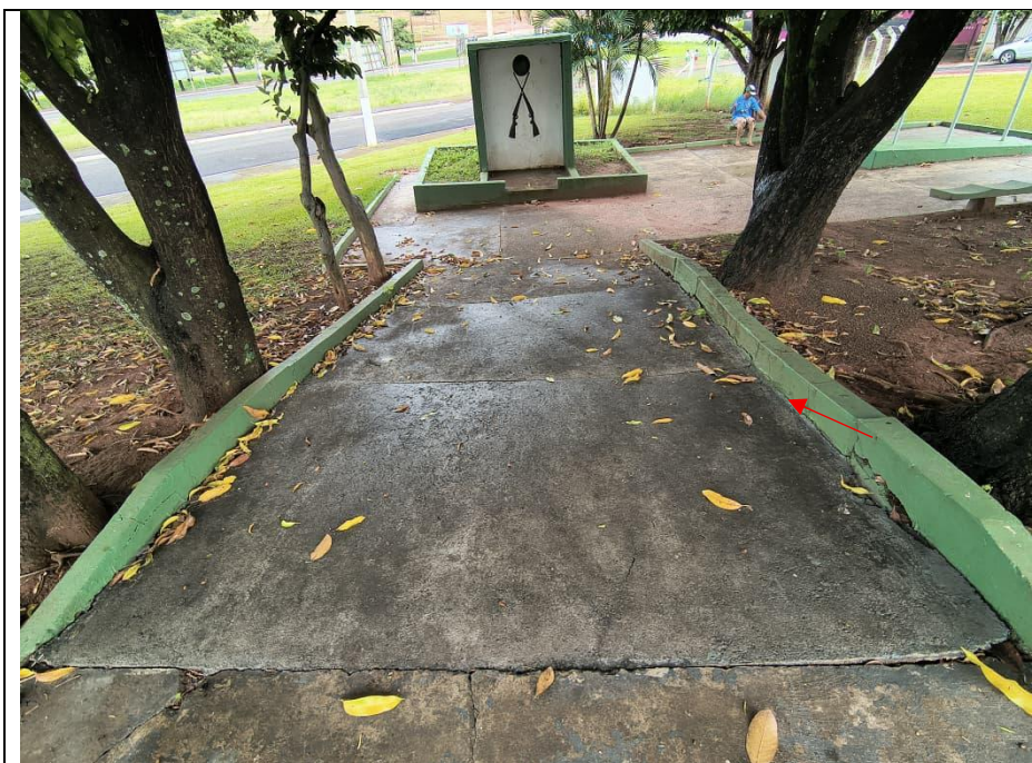
Figura 4 – A praça mostra desgaste relevante na estrutura e no piso de concreto, recomendando-se intervenções corretivas, como reparo do piso, construção de sistema de drenagem pluvial e revitalização.
