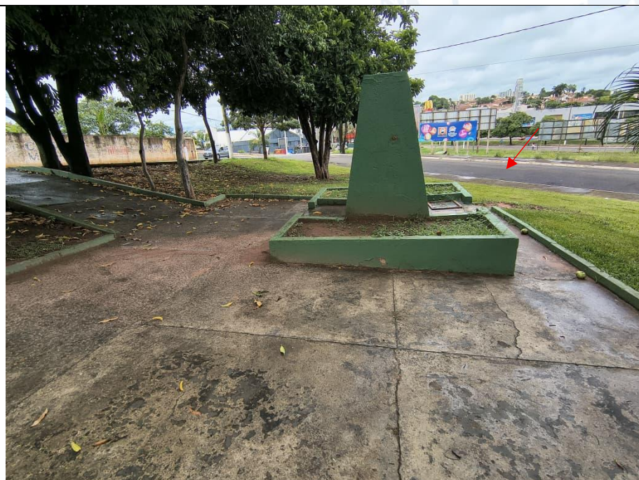
Figura 3 – A praça mostra desgaste relevante na estrutura e no piso de concreto , recomendando-se intervenções corretivas, como reparo do piso, construção de sistema de drenagem pluvial e revitalização.
